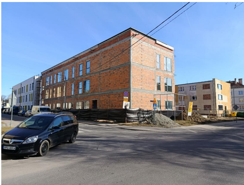
Budynek Zespołu Placówek Specjalnych w trakcie przebudowy- widok od ul. Zielonej. Foto – Starostwo Powiatowe w Pleszewie
