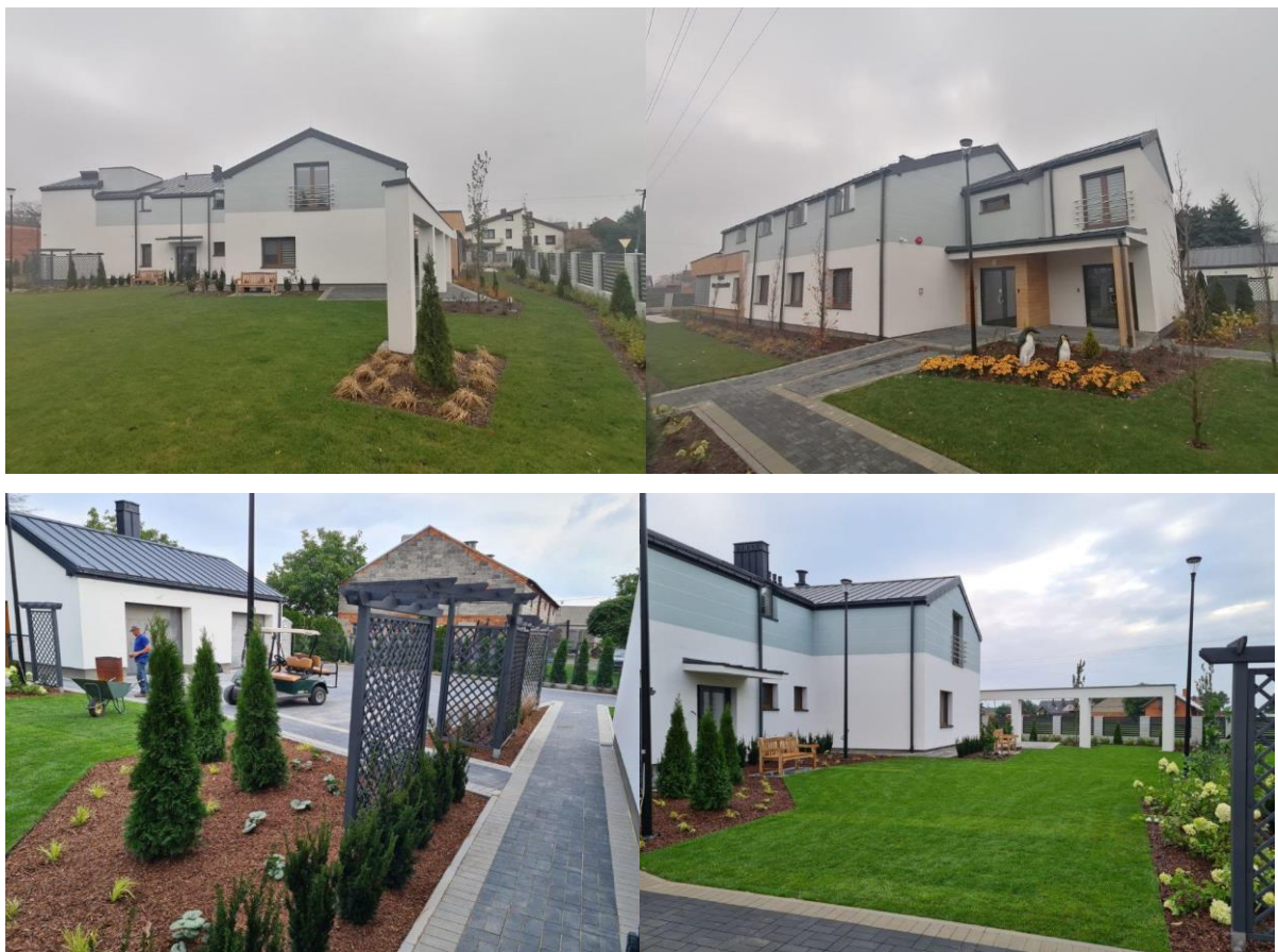
zdjęcie nr 29,30,31,32 - DPS Broniszewice - nowopowstałe budynki „DRUGI DOM CHŁOPAKÓW”.
