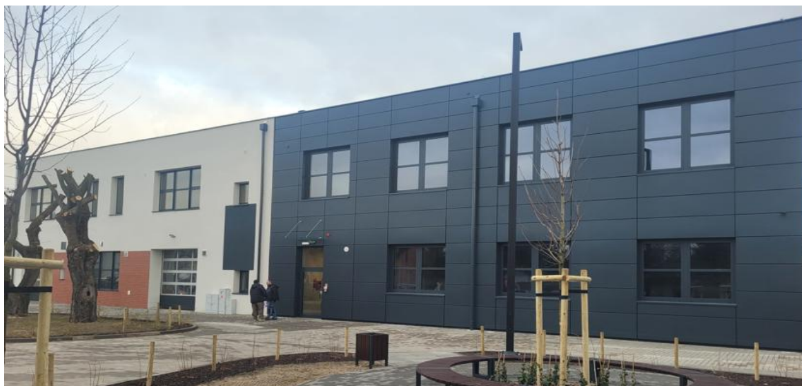
zdjęcie nr 1 -Budynek Centrum Kształcenia Zawodowego w Pleszewie
